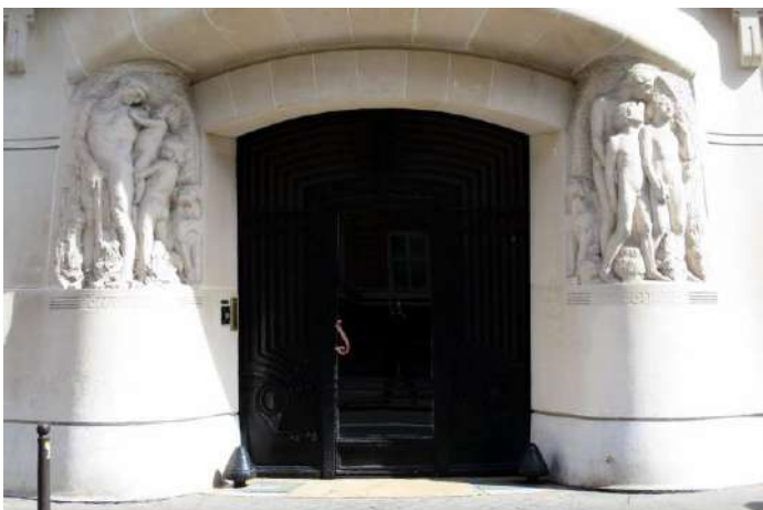
Porte du 67 boulevard Raspail, 75006. Immeuble construit par Léon Tossier en 1913
