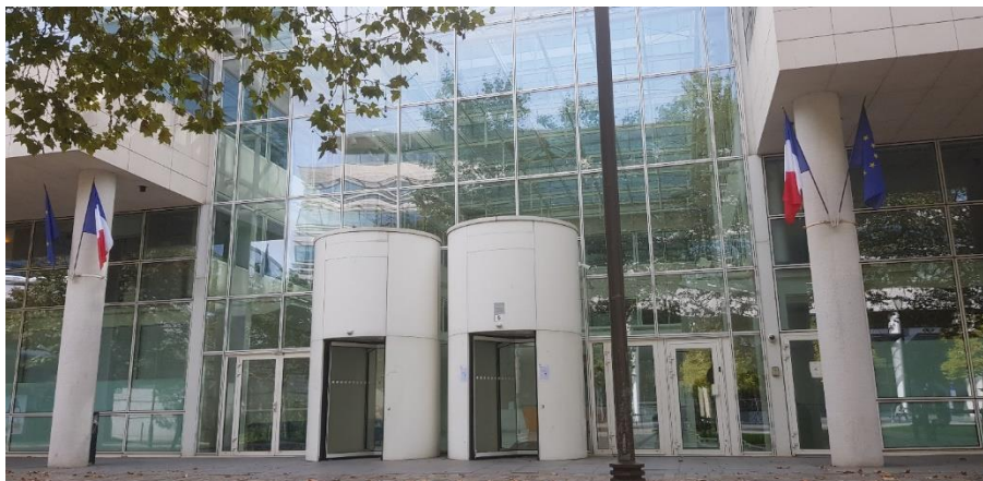
Bâtiment Douanes Paris - Bercy
